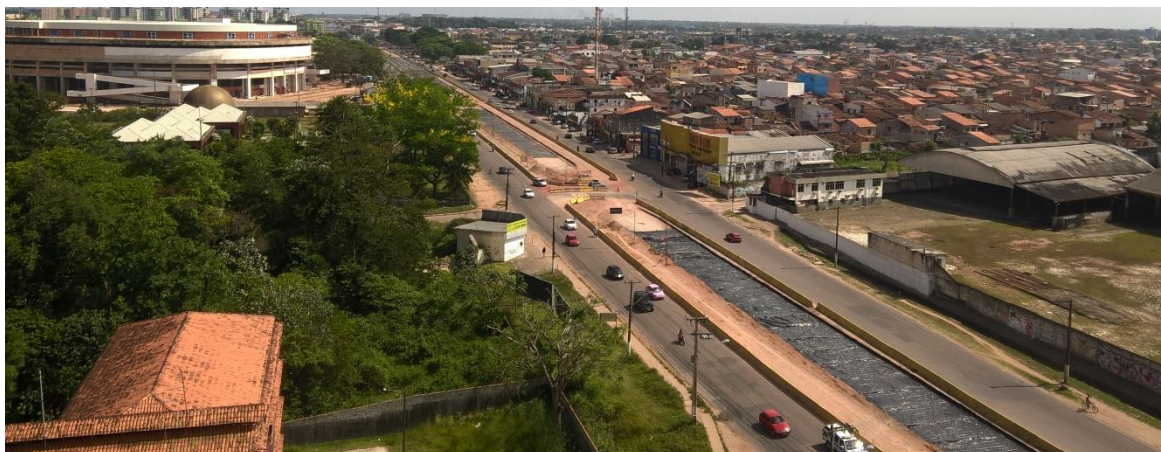
Figura 1.12: Trecho da Obra do BRT na faixa central da Avenida Augusto Montenegro.
