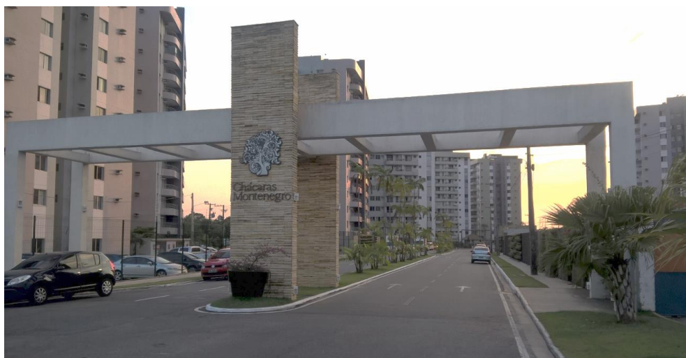
Figura 4.5: Acesso ao Condomínio fechado Chácara Montenegro
