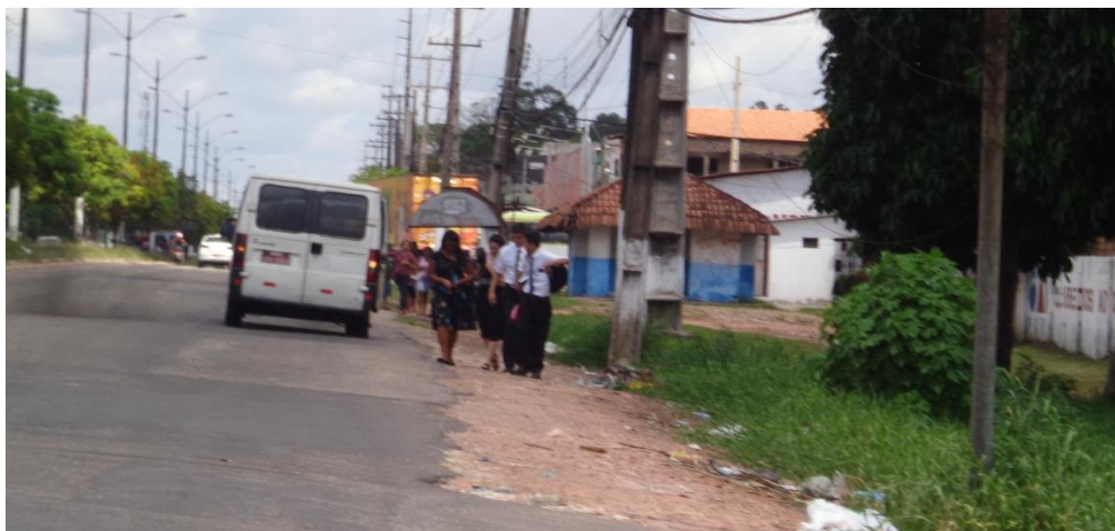
Figura 4.8: Ausência de pavimentação adequada para circulação do pedestre e acesso ao ponto de parada de transporte coletivo.
